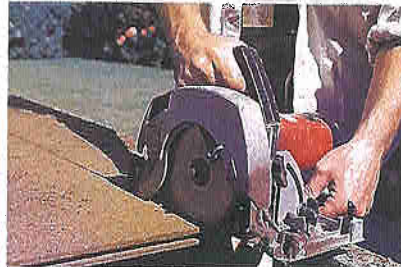
Coupe à dimension du panneau Celit 4D
